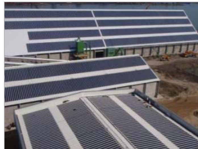
Lieu : Fos-sur-Mer (Bouches du Rhône) Capacité : 456 kWc Fournisseur : Unisolar Type de bâtiment : Hangars de stockage industriels
